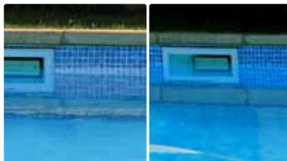
Conduite d'eau d'une piscine
